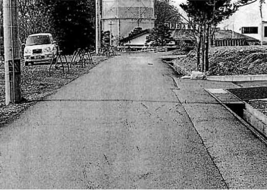
現在は市道になっている 「森林軌道」跡（山崎町地内）
