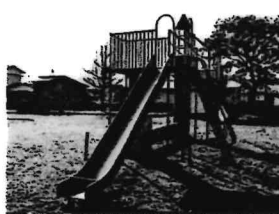
複合遊具撤去前
